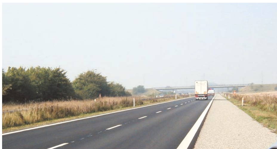
Figur 3. Det færdige slidlag bestående af 2,2 cm Combifalt 8 udlagt på betonmotorvejen.
