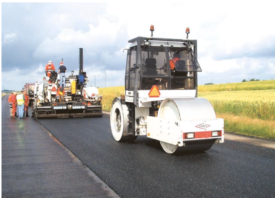
Figur 2. Udlægning af Combifalt 8 på den forklæbede betonoverflade.
