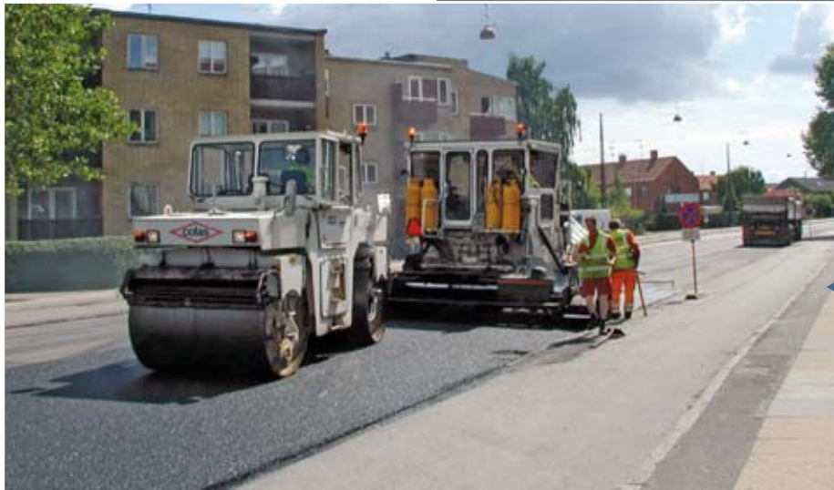
Figur 9. Udlægning på Kastrupvej.
