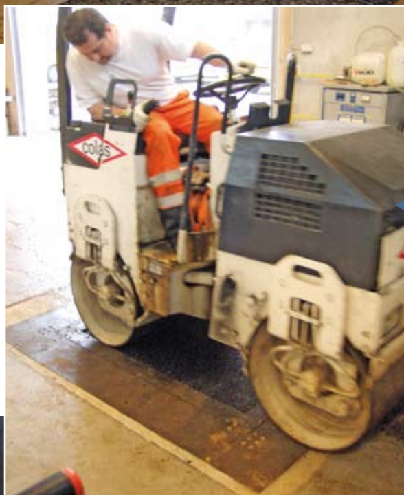
Figur 3. Komprimering af asfaltplader.
