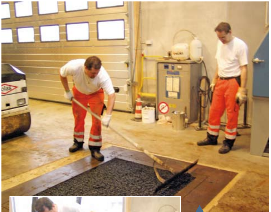
Figur 2. Fremstilling af asfalt-plader hos Vejteknisk Institut.
