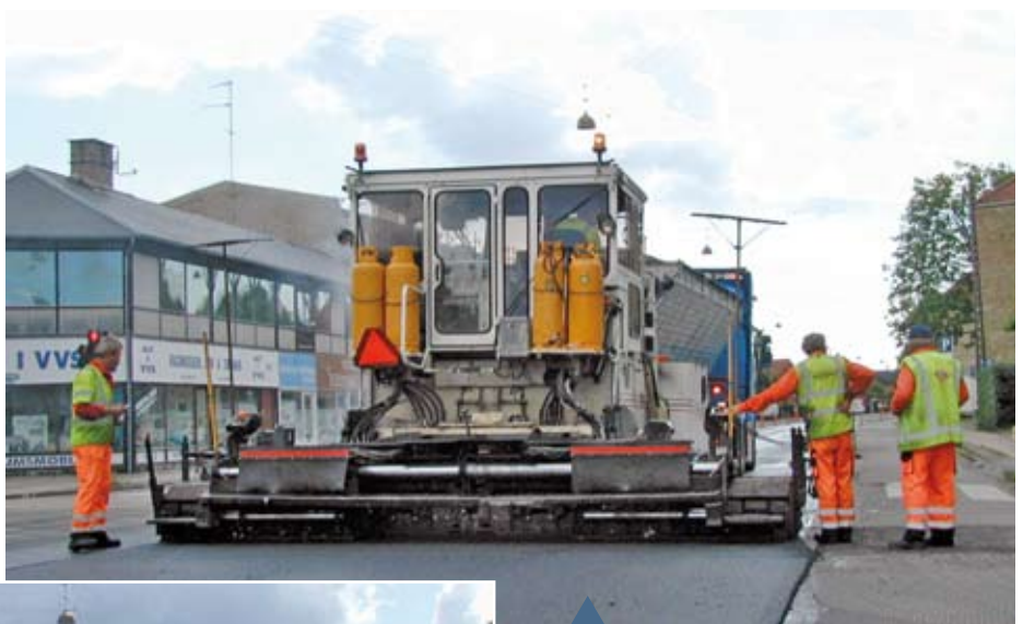
Figur 8. Udlægning af støjdæmpende skærvemastiks på Kastrupvej.
