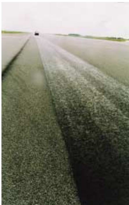
Figur 5. Forsegling af startbanen med 450 gram Colacid 50 HF emulsion pr. m 2 .
