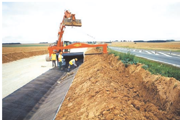
Figur 2. Indbygning af Colétanche i grøfter langs RN 154 nær Chartres, Frankrig.
