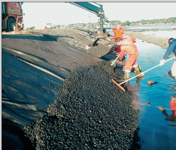
Fig. 1: Arbejde med kystsikring med asfalt.
