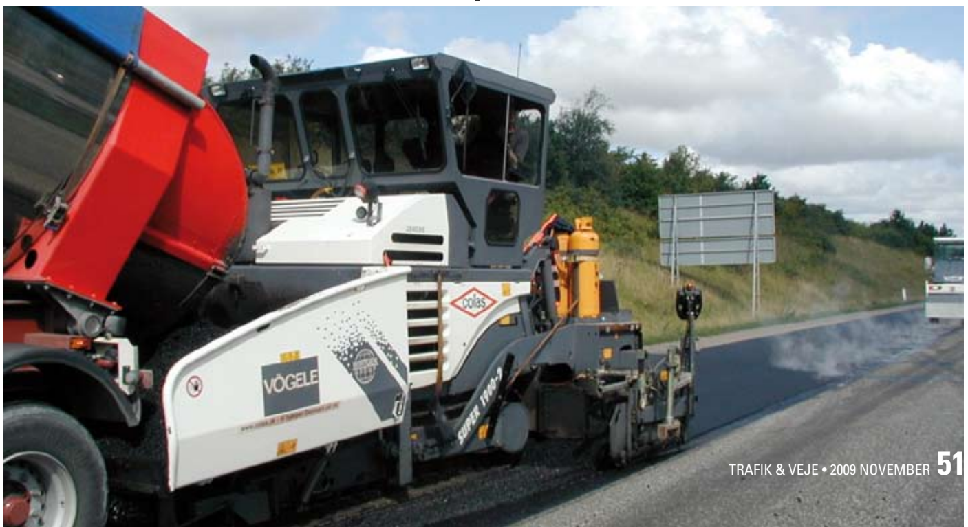
Figur 5. Udlægning af 2,5km HM-Asfalt bindelag i det tunge spor på M70.
