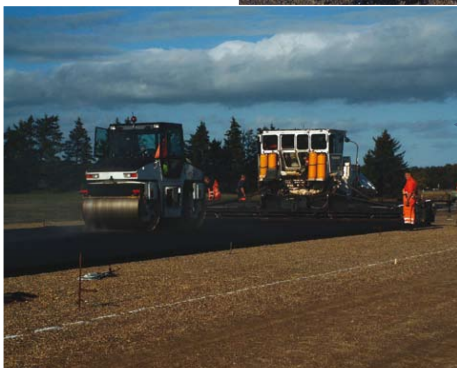
Figur 3. Finn Thogersen, Vejteknisk Institut, Indbygning af tøjningsmålere.
