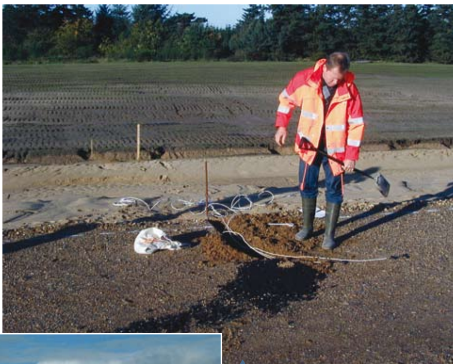
Figur 3. Finn Thogersen, Vejteknisk Institut, Indbygning af tøjningsmålere.
